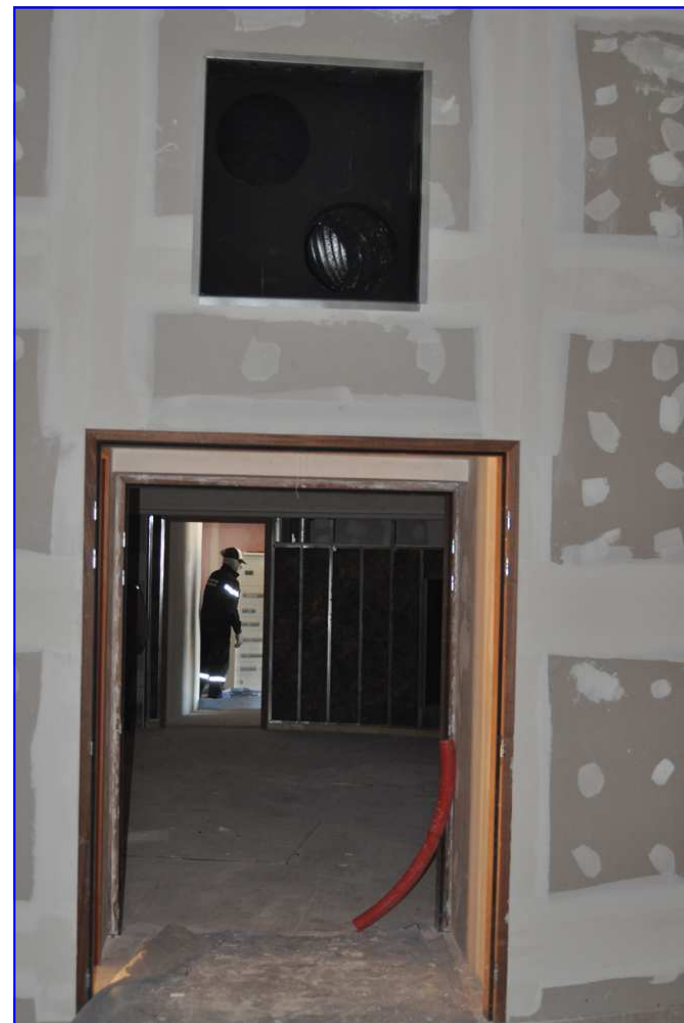
Le sas d'entrée de la coupole.
