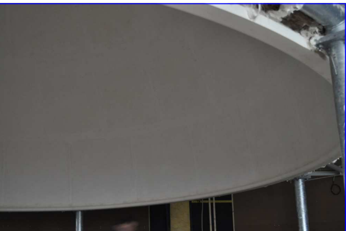
La coupole-écran de 8 mètres est achevée. On distingue encore les joints entre les différents éléments. Après l'application de la couche de peinture de finition, la coupole présentera un aspect uniforme. La teinte sera grise très claire, presque blanche, et présentant un coefficient de réflexion bien déterminé afin de ne pas provoquer d'images parasites.
