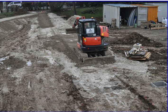
Aménagement des abords du nouveau Planétarium en cours. L'entrée du périmètre se situera en haut et gauche de la photo. On voit, à gauche, l'esquisse de la rampe d'accès à l'entrée du bâtiment.
