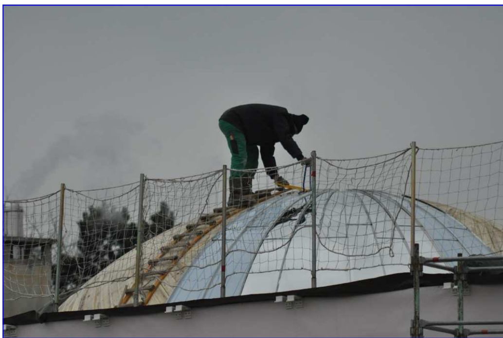
Pose de la couverture de la partie sommitale de la coupole en acier inoxydable sur lattis en bois
